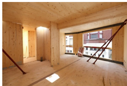
Figuur 20. Houtmassiefbouw in uitvoering
