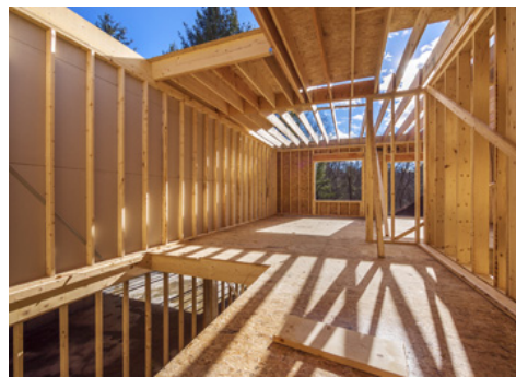
Figuur 19. Houtskeletbouw in uitvoering
